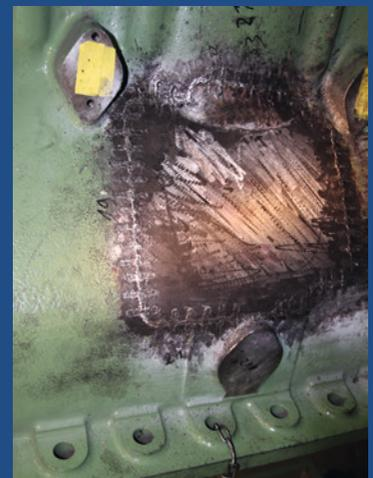
Die im Metalock-Verfahren ausgeführte Reparatur hält höchsten Belastungen stand
